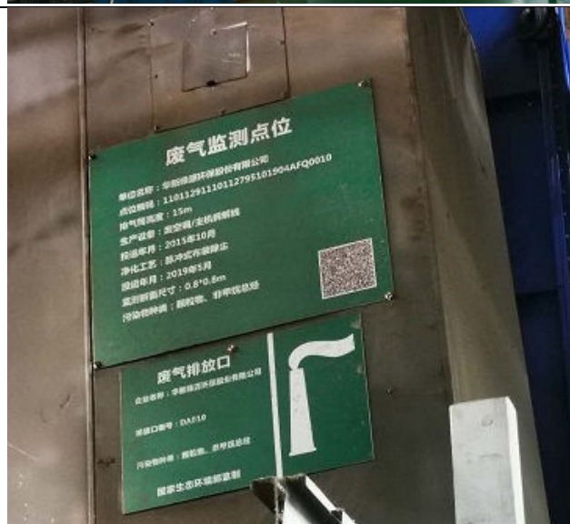
空调拆解线 DA010
